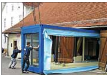
Die Containerlösung bei der Bücherei Aldingen hat sich bewährt - hier startet der Remsecker Lesesommer
